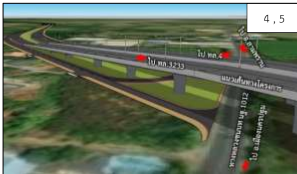
ทางยกระดับข้ามถนนทางหลวงชนบท สาย นร.1012 และจุดกลับรถใต้สะพาน
