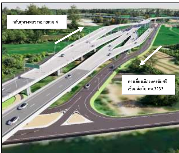
รูปที่ 7-6 Y Type (Y Interchange หรือ Directional Ramp) บริเวณชิดขอบทางเท้า (ต่อ)
