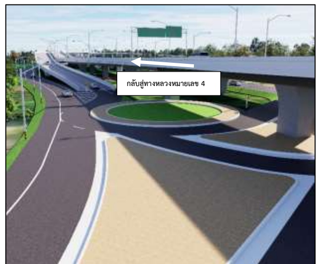
รูปที่ 7-6 Y Type (Y Interchange หรือ Directional Ramp) บริเวณชิดขอบทางเท้า (ต่อ)
